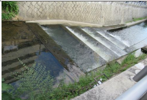
魚が移動しやすい魚道に改修を！ ( 阪急神戸線の北側 )
